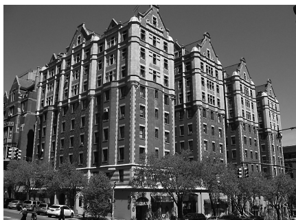
ウィティア・ホールの外観 (Photo Courtesy: TC Office of Residential Services)
